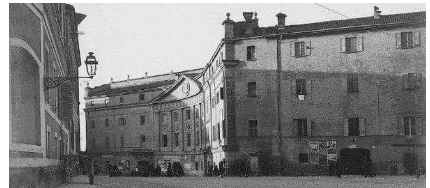
1908. Vista da viale Berengario del fabbricato costruito sopra la Porta San. Agostino
